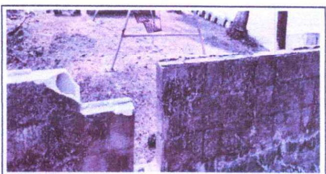
REPARACIÓN DE MURO PERIMETRAL DE BLOCK
