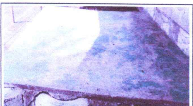
SUSTITUCIÓN DE PISO DE TORTA DE CONCRETO DEL ESCENARIO
