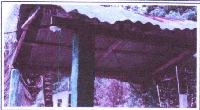
MANTENIMIENTO A ESTRUCTURA DE SOPORTE DE METAL DEL ESCENARIO
