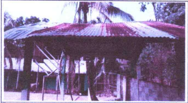
SUSTITUCIÓN DE LÁMINA, POR LÁMINA TROQUELADA ALUZINC LIBRE 26 DEL ESCENARIO
