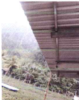
FOTO 1: SUSTITUCION DE ESTRUCTURA METAL PARA SOPORTE DE TECHO
