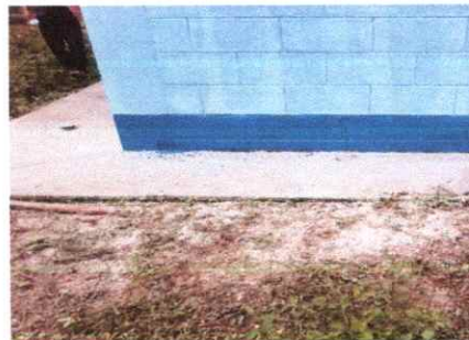
FOTO 6: PINTURA MUROS INTERIOR Y EXTERIOR
