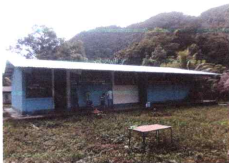
FOTO 5: PINTURA EN MUROS INTERIOR Y EXTERIOR
