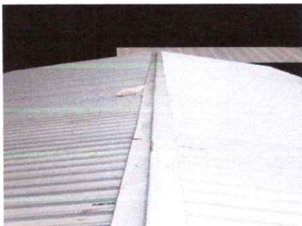
FOTO 3: SUSTITUCION DE LAMINA POR LAMINA TROQUEALDA CAL.26
