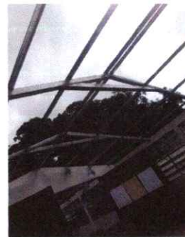
FOTO 2: SUSTITUCION DE ESTRUCTURA METAL PARA SOPORTE DE TECHO
