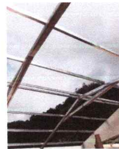
FOTO 6: SUSTITUCION DE ESTRUCTURA METAL PARA SOPORTE DE TECHO
