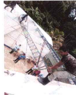
FOTO 4: SUSTITUCION DE ESTRUCTURA METAL PARA SOPORTE DE TECHO
