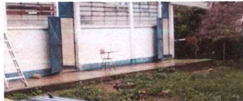
FOTO 16: MANTENIMIENTO DE PUERTAS DE METAL
