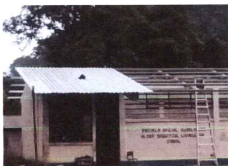
FOTO 7: SUSTITUCION DE LAMINA POR LAMINA TROQUEALDA CAL.26
