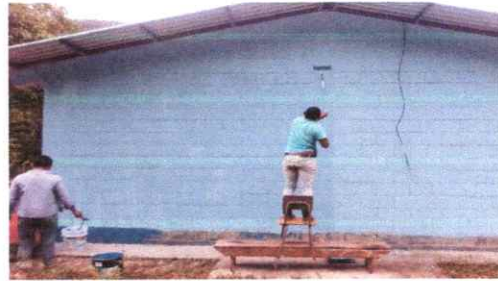
FOTO 14: PINTURA MUROS INTERIOR Y EXTERIOR
