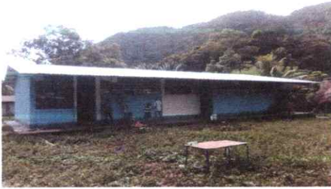
FOTO 13: PINTURA MUROS INTERIOR Y EXTERIOR
