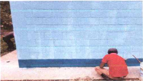
FOTO 15: PINTURA MUROS INTERIOR Y EXTERIOR
