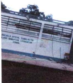
FOTO 5: SUSTITUCION DE ESTRUCTURA METAL PARA SOPORTE DE TECHO
