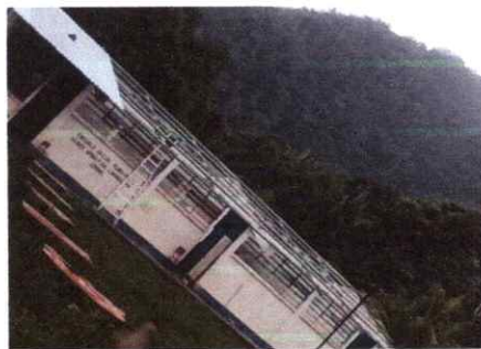
FOTO 8: SUSTITUCION DE LAMINA POR LAMINA TROQUEALDA CAL.26
