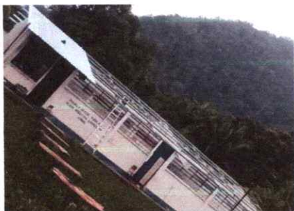
FOTO 9: SUSTITUCION DE LAMINA POR LAMINA TROQUEALDA CAL.26
