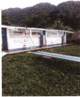
FOTO 1: SUSTITUCION DE ESTRUCTURA METAL PARA SOPORTE DE TECHO
