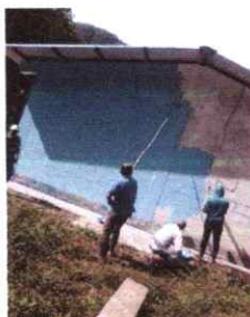
FOTO 11: PINTURA MUROS INTERIOR Y EXTERIOR
