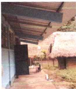
FOTO 17: MANTENIMIENTO DE PUERTAS DE METAL
