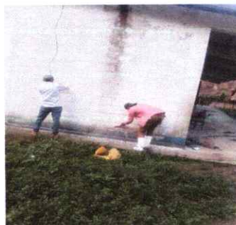
FOTO 10: MANTENIMIENTO DE PARED PARA PINTURA
