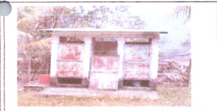
5. Mantenimiento a estructura (lijado, cambio de tubo , cepillado, sujeciones, aplicación de pintura) a puertas servicios sanitarios
