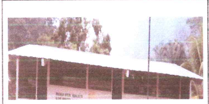
1 Sustitución de lámina, por lamina troquelada aluzinc calibre 26, aula y baños
