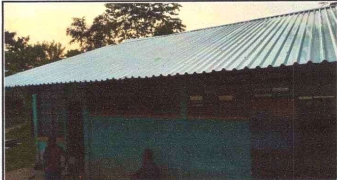
Foto 2: Instalada de laminas.
