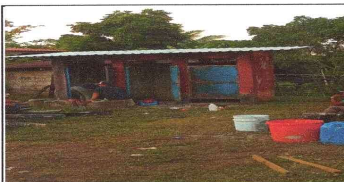
Foto 5: Mantenimiento de servicio sanitarios y sus accesorios
