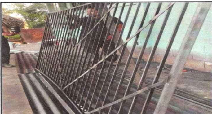
Foto 3: Sustitucion de ventanas a balcones de metal.
