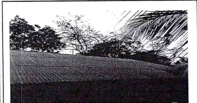
1 Sustitución de lámina, por lamina troquelada aluzinc calibre 26, aula y baños
