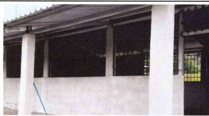
SUSTITUCIÓN DE PUERTA Y VENTANAS
