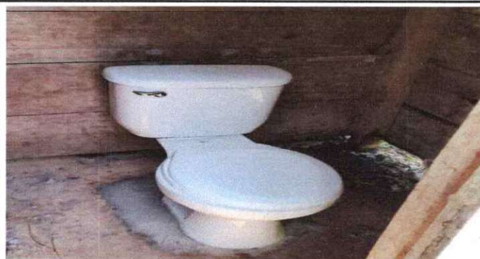
SUSTITUCIÓN DE INODORO
