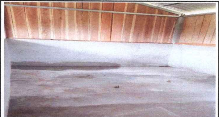
SUSTITUCIÓN DE PISO DE TORTA DE CONCRETO
