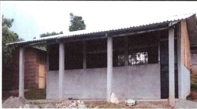
SUSTITUCIÓN DE LAMINA Y SUSTITUCIÓN DE SOPORTE DE MADERA, POR METAL
