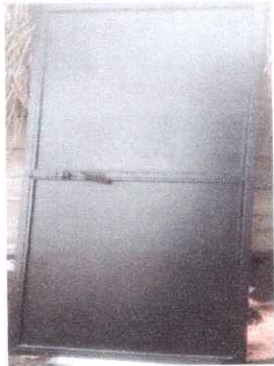
3. Sustitución de puerta de madera a metal
