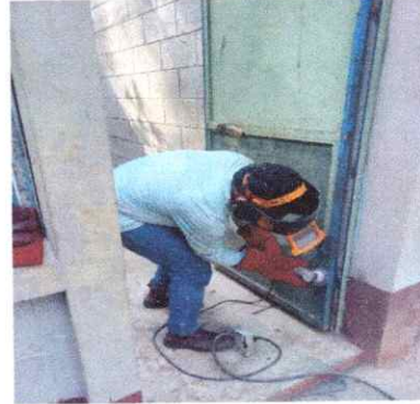
2. Mantenimiento de puerta de metal
