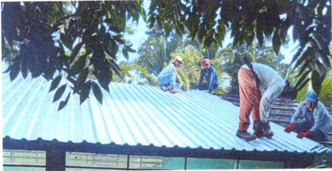
1. Instalando láminas troquelada calibre 26
