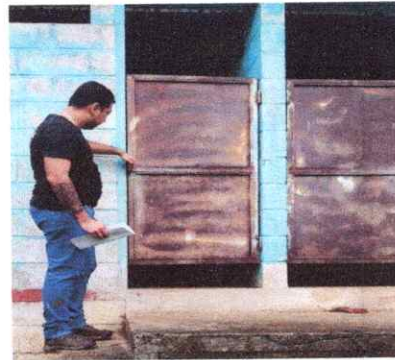
4. Mantenimiento a puerta de servicio sanitario
