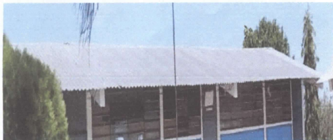
1 Sustitución de lámina, por lámina troquelada aluzinc calibre 26
