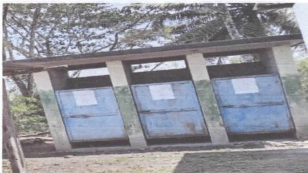
5 Mantenimiento a estructura (lijado, cambio de tubo , cepillado, sujeciones, aplicación de pintura) a puertas servicios sanitarios
