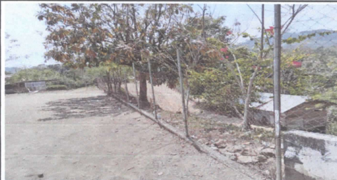
4 Reparación de muro perimetral de block con tubo hg y malla galvanizada, soleras intermedias y columnas.
