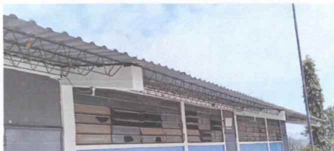
3 Sustitución de estructura de metal de ventana
