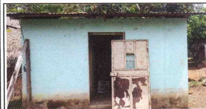
Foto 5: Fabricación en Instalación de Puerta en Baños.
