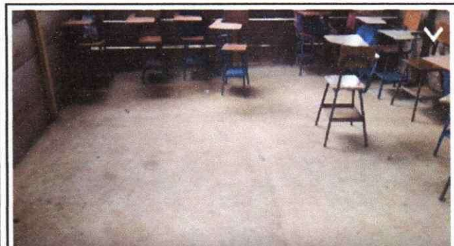
Foto 3: Sustitución de piso de cemento líquido
