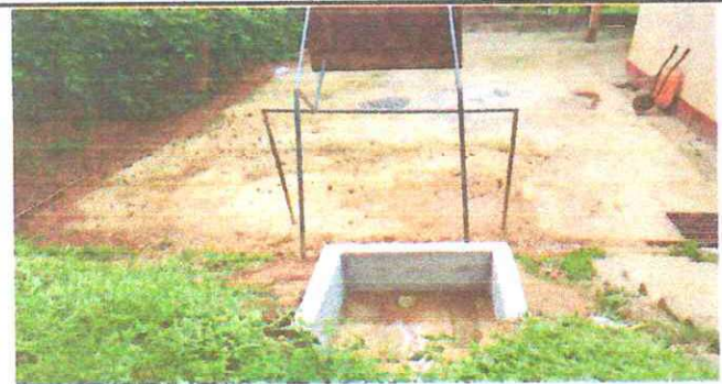
Foto 3: Reparacion de cuneta de concreto
