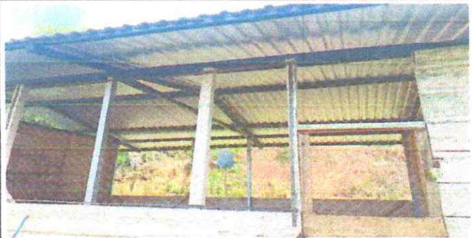
Foto 6: Fabricacion de Balcon con Malla Metalica y Base de metal
