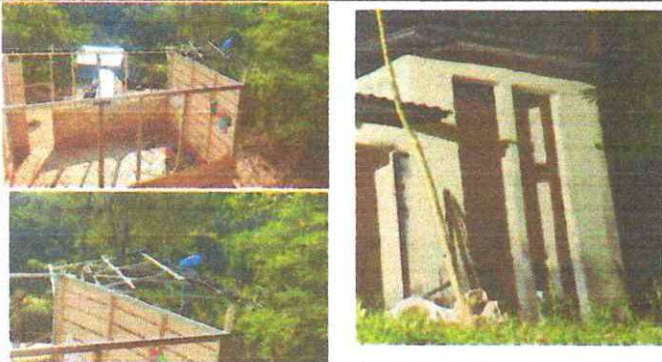
Foto 1: Sustitucion de lámina, lámina aluzinc calibre 26 en aula, cocina y baño.
