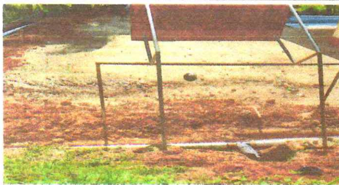
Foto 3: Reparacion de cuneta de concreto
