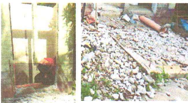
Foto 6: sustitucion de inodoros y sutitucion de piso de torta de concreto
