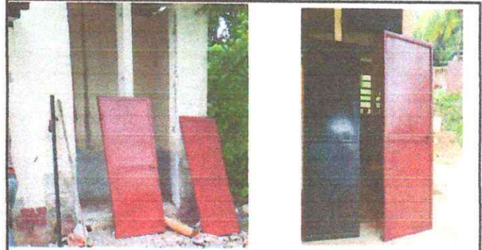
Fotos 4: Sustitucion de Puertas de Baños y Aula
