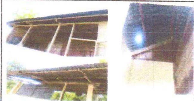
Foto 2: Sustitución de estructura de soporte de madera, por metal en Aula, Cocina y Baño
