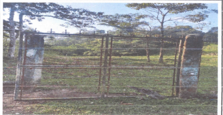
FOTO 4: Fabricación e instalación de portón de metal de ingreso
