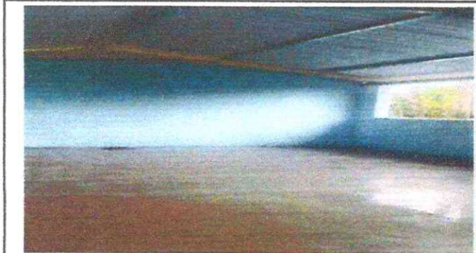
Foto 3: SUSTITUCIÓN DE TORTA DE CEMENTO
