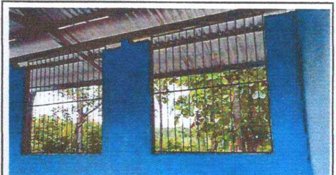
Foto 4: REPARACIÓN DE PAREDES Y COLUMNAS DE CEMENTO
