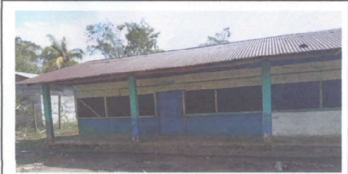
1 Sustitución de lámina, por lámina troquelada aluzinc calibre 26,
