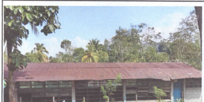
1 Sustitución de lámina, por lámina troquelada aluzinc calibre 26,
