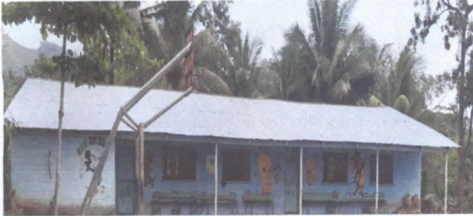
1 Sustitución de lámina, por lámina troquelada aluzinc calibre 26,
