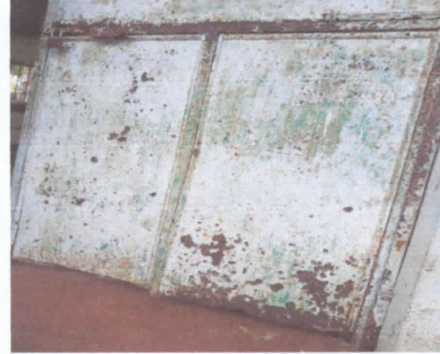
2. Sustitución de puerta
