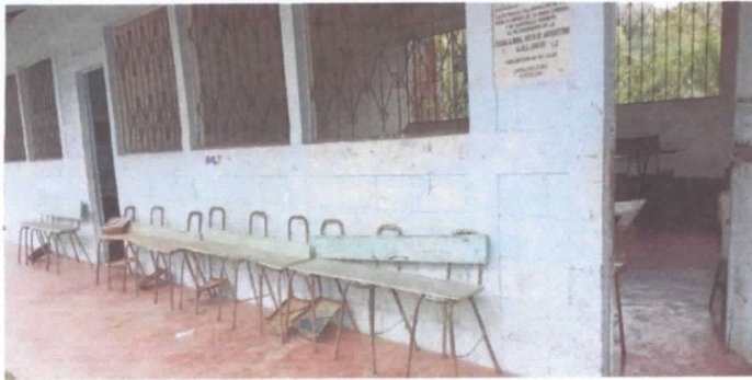
3 Pintura en muros exteriores e interiores
