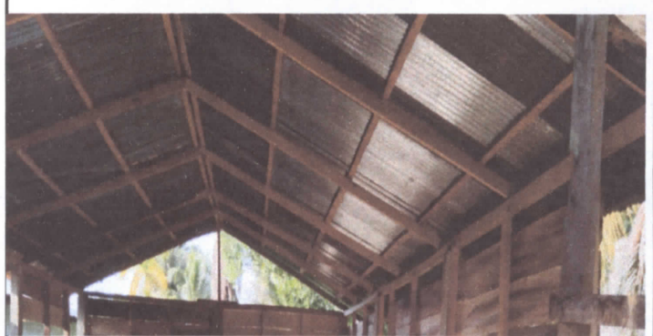
SUSTITUCIÓN DE LÁMINA POR LÁMINA TROQUELADA
