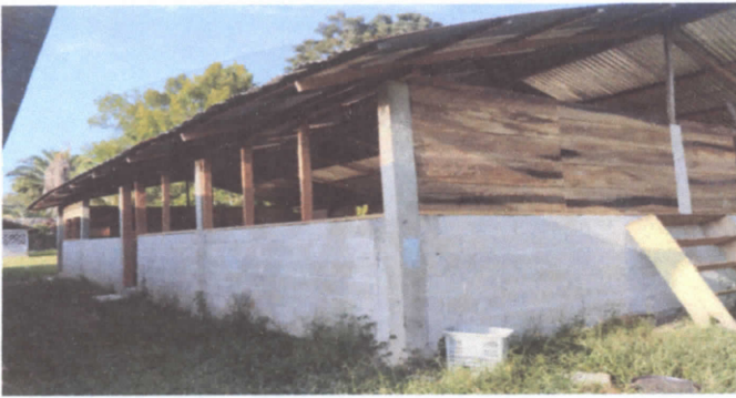
REPARACIÓN DE PLANCHAS DE CONCRETO DE PATIO
