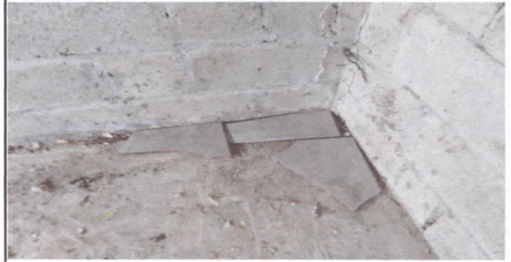
REPARACIÓN DE PISO CERÁMICO
