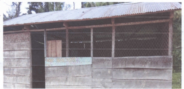
FOTO 4: SUSTITUCION DE ESTRUCTURA DE METAL DE VENTANA
