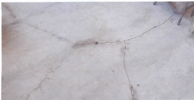
FOTO 5: SUSTITUCION DE PISO DE TORTA DE CONCRETO
