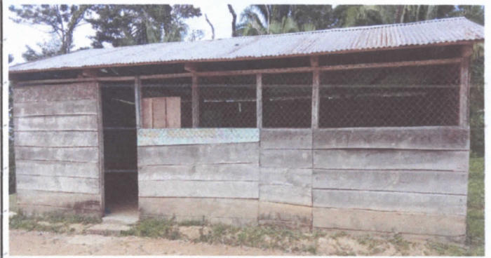
FOTO: 2 SUSTITUCION DE LAMINA POR LAMINA ALUZINC CALIBRE 26
