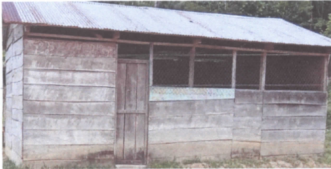
FOTO3: SUSTITUCION DE PUERTA
