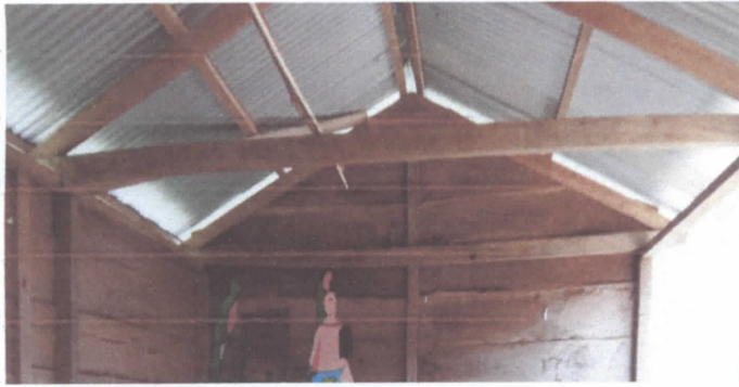
FOTO: SUSTITUCION DE ESTRUCTURA DE SOPORTE DE MADERA POR METAL
