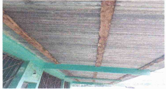
2 Sustitución de estructura de soporte de madera, por metal
