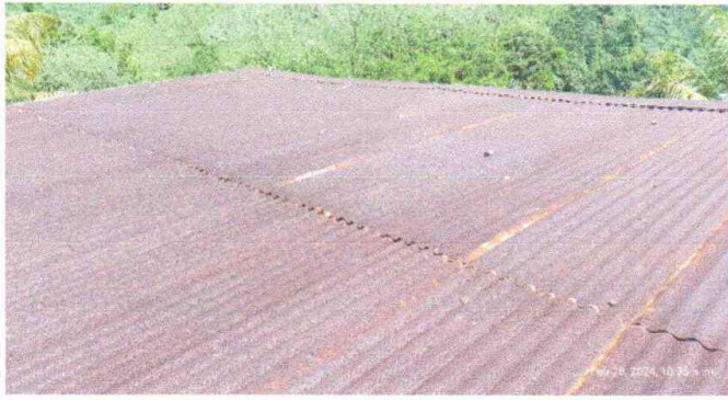
1 Sustitución de lámina, por lámina troquelada aluzinc calibre 26
