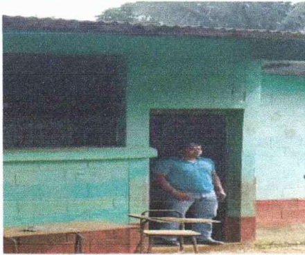
3 Sustitución de puerta
