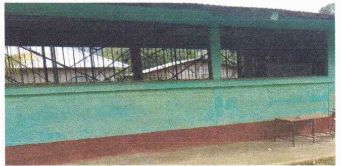
4 Pintura en muros exteriores e interiores
