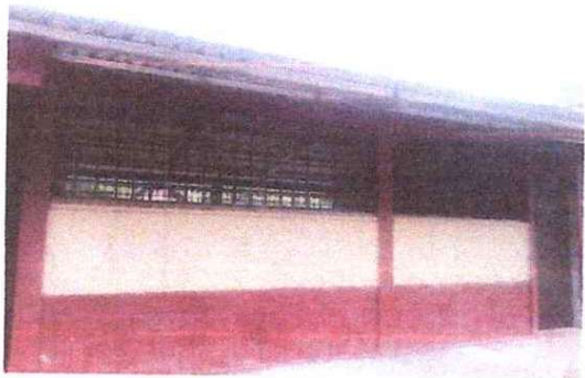
FOTO 3: INSTALACION DE BALCONES
