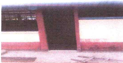
FOTO 5: INSTALACION DE PUERTA DE METAL
