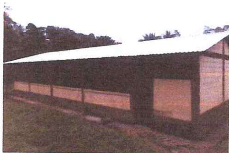
FOTO 3: SUSTITUCION DE LAMINA TROQUELADA CAL. 26
