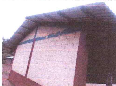
FOTO 4: SUSTITUCION DE LAMINA TROQUELADA CAL. 26
