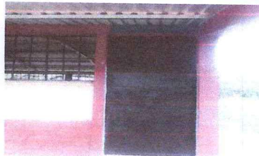
FOTO 6: INSTALACION DE PUERTA DE METAL
