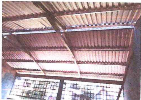
FOTO 1: INSTALACION DE ESTRUCTURA DE SOPORTE DE METAL
