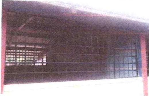
FOTO 1: INSTALACION DE BALCONES
