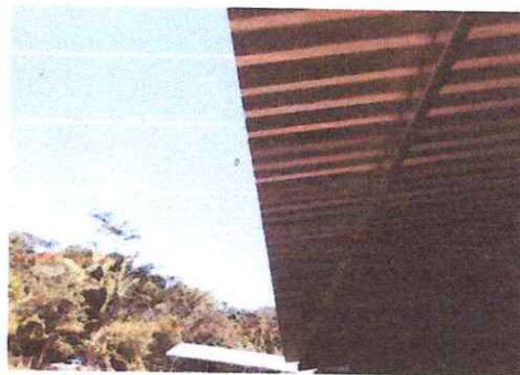
FOTO 2: INSTALACION DE ESTRUCTURA DE SOPORTE DE METAL
