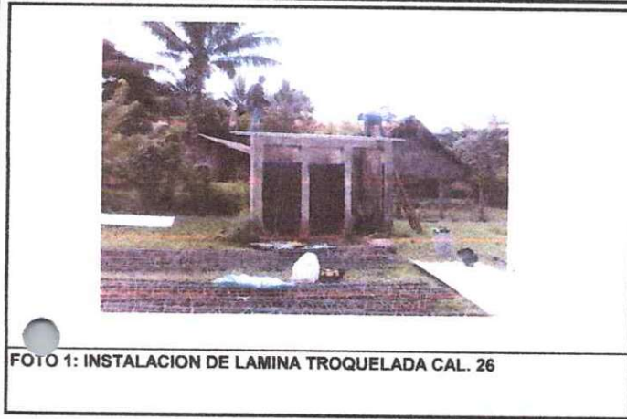
FOTO 2: INSTALACION DE LAMINA TROQUELADA CAL. 26
