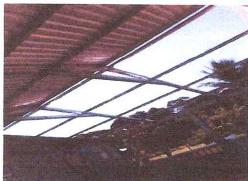
FOTO 3: INSTALACION DE LAMINA TROQUELADA CAL.26
