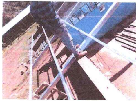
FOTO 2: INSTALACION DE ESTRUCTURA DE METAL
