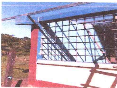
FOTO 5: INSTALACION DE BALCONES
