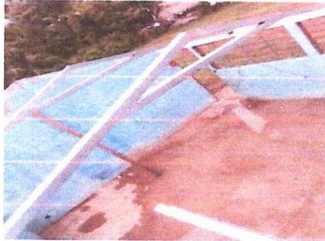
FOTO 1: INSTALACION DE ESTRUCTURA DE METAL
