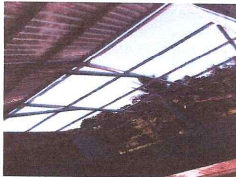
FOTO 4: INSTALACION DE LAMINA TROQUELADA CAL.26
