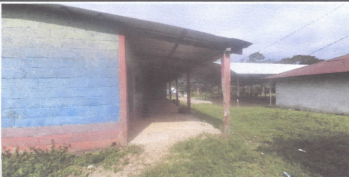
Anexo 5: Reparación de piso del aula.
