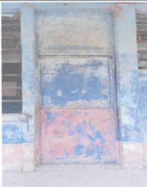
FOTO 3 Sustitución de puerta
