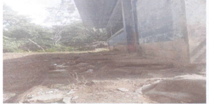
FOTO 2 Reparación de planchas de concreto de patio
