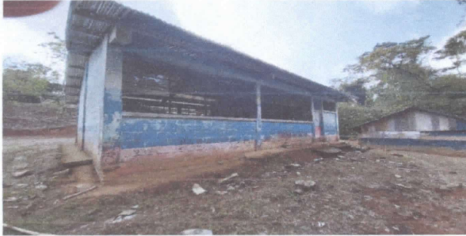
FOTO 1 Reparación de planchas de concreto de patio
