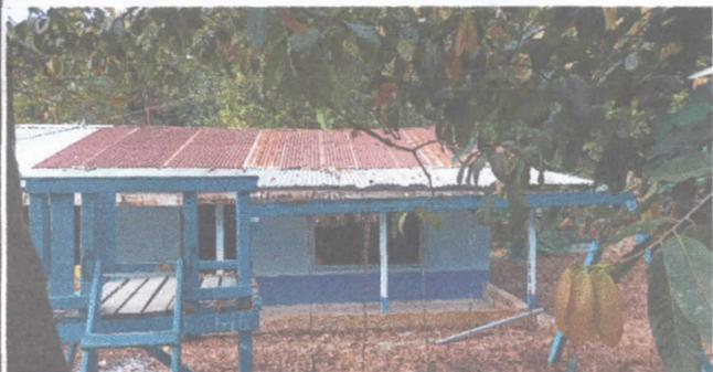
sustitución de estructura de madera por metal y cambio de lamina, al salon de párvulos.
