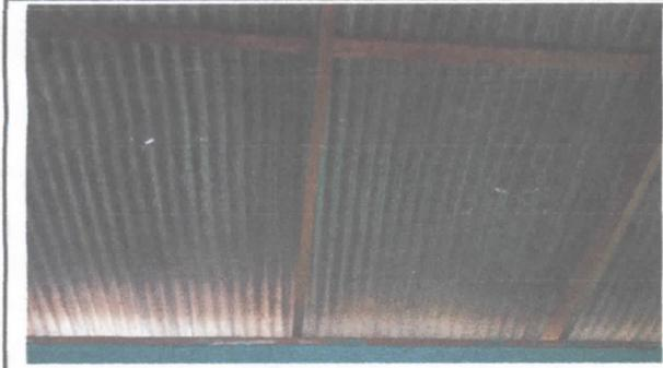
sustitución de estructura de madera por metal y cambio de lamina, al corredor principal de la escuela.
