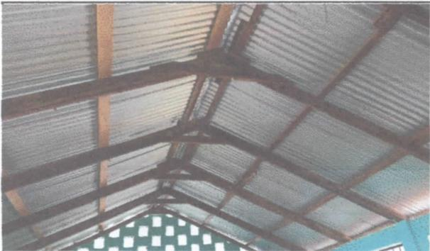
sustitución de estructura de madera por metal y cambio de lamina, a los salones de cuarto y sexto primaria.
