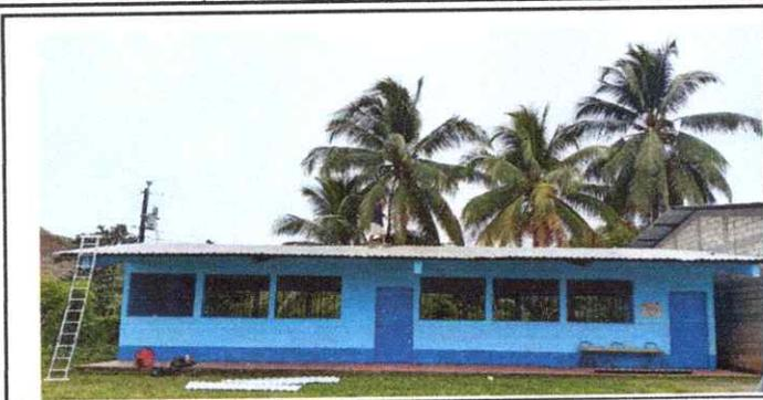
Foto 1: LAMINA TROQUELADA CALIBRE 26 INSTALADA
