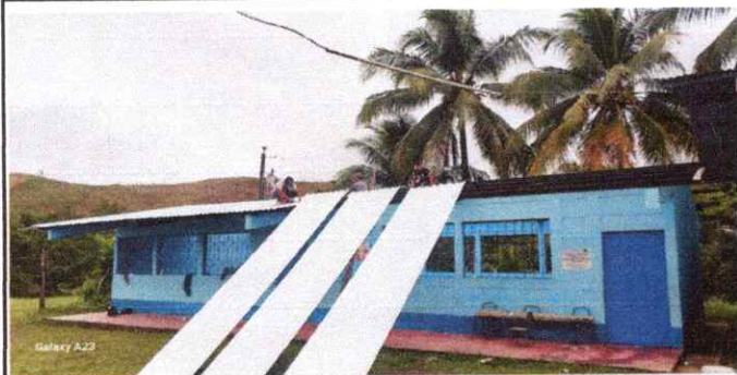
Foto 1: INSTALACIÓN DE LÁMINA TROQUELADA CALIBRE 26
