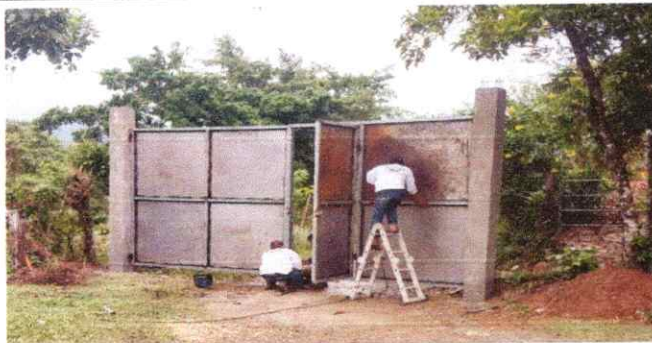
Foto 3: INSTALANDO PORTÓN PRINCIPAL
