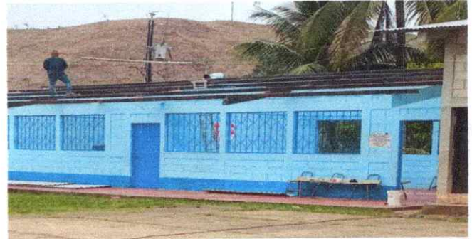
Foto 2: MANTENIMIENTO DE ESTRUCTURA METALICA
