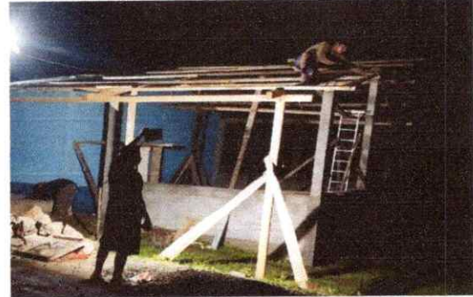
Foto 4: AMPLIACIÓN DE REFUERZO ESTRUCTURAL
