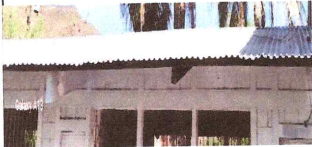
Foto 1: Sustitución de lámina, por lamina troquelada aluzinc calibre 26
