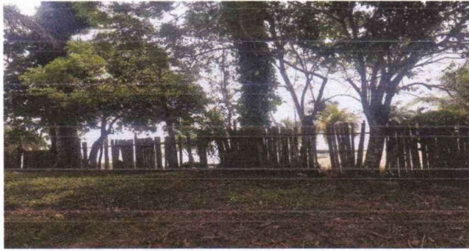
FOTO 1: SUSTITUCION DEMURO PERIMETRAL LADO DERECHO.
