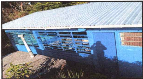
Foto 1: SUSTITUCIÓN DE TUBO DE PVC DE BAJADA DE AGUA PLUVIAL POR CANAL DE PVC
