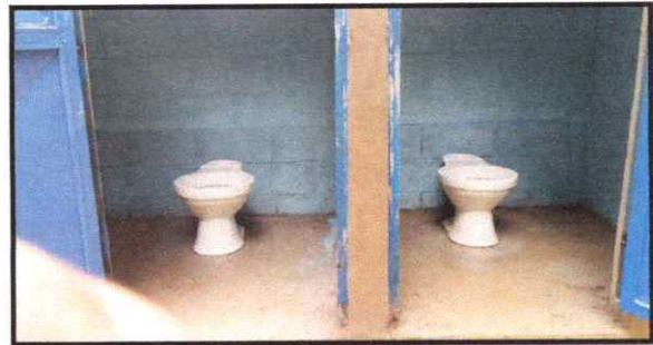
Foto 4: SUSTITUCIÓN DE SANITARIOS
