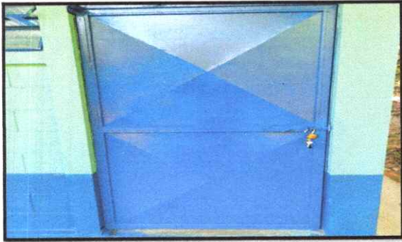
Foto 3: MANTENIMIENTO DE PUERTAS
