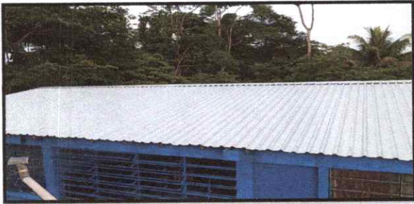
Foto 1: SUSTITUCION DE LAMINAS, POR LAMINA TROQUELADA ALUZINC CALIBRE 26
