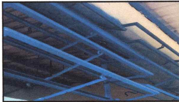
Foto 2: REPARACIÓN DE MARCOS PARA VENTANAS
