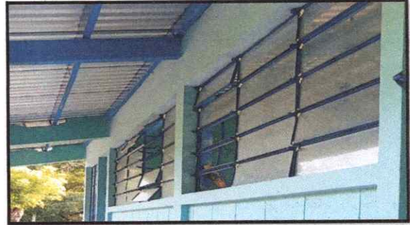
Foto 2: MANTENIMIENTO DE ESTRUCTURA METALICA DE VENTANAS
