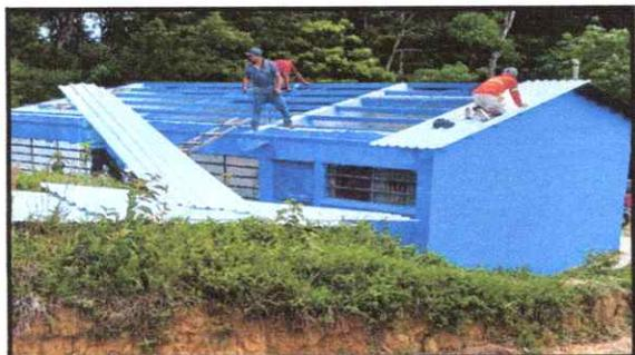
Foto1: SUSTITUCION DE LAMINAS, POR LAMINA TROQUELADA ALUZINC CALIBRE 26
