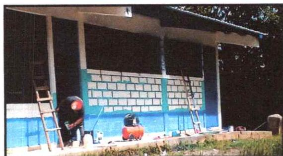
Foto 5: PINTURA DE MUROS EXTERIORES Y INTERIORES
