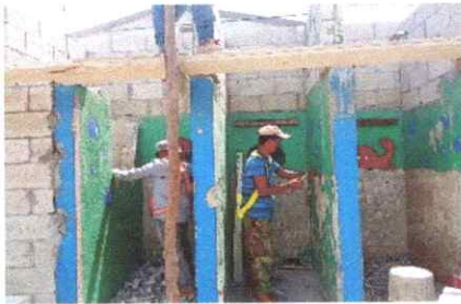
Foto1: Se quitaron las puertas de los baños.
