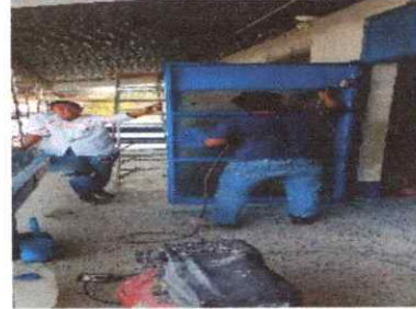
Foto 2: Trabajando en las puertas de las aulas del segundo nivel
