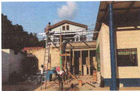
Foto 3: Trabajando en el techo de los baños
