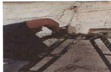
Foto 6: Trabajando en el sistema eléctrico.
