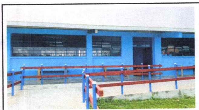
Foto 9: Finalización barandas de metal.
