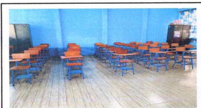
Foto 3: Finalización de piso cerámico aula de segundo básico
