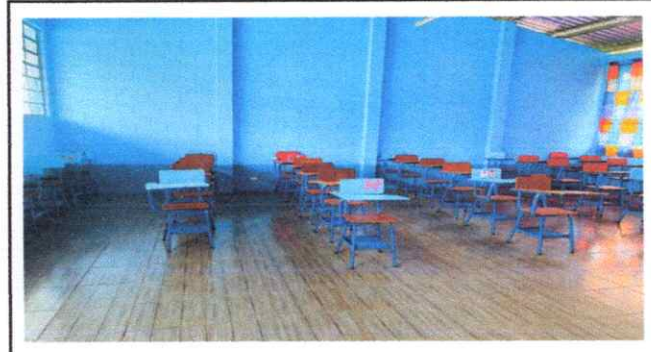
Foto 2: Finalización de piso cerámico aula de primero básico.
