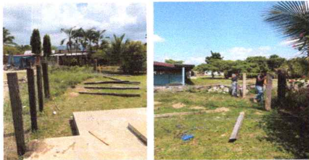
Foto 3: Proceso de reparación de cerco de alambre de pua.
