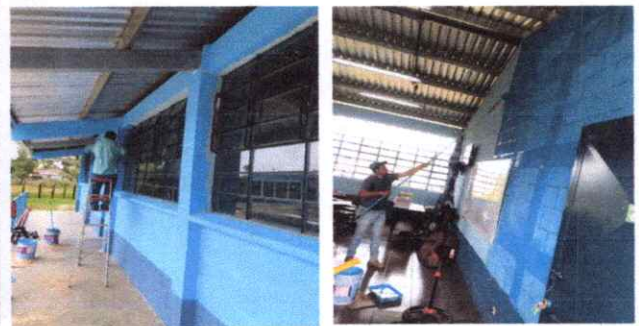
Foto 4: Proceso de pintura en muros exteriores e interiores.
