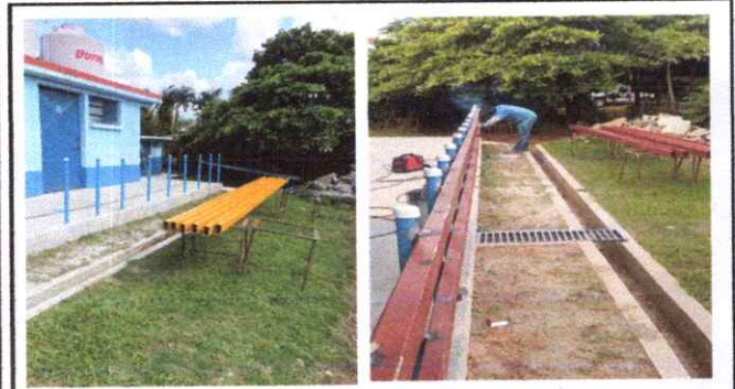
Foto7: Sustitución de barandas de metal.
