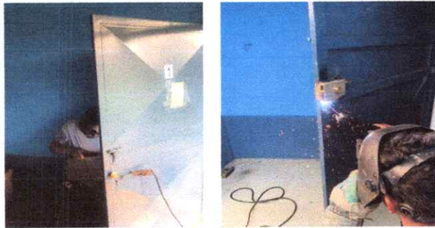
Foto 1: Proceso de sustitución de chapas en mal estado.
