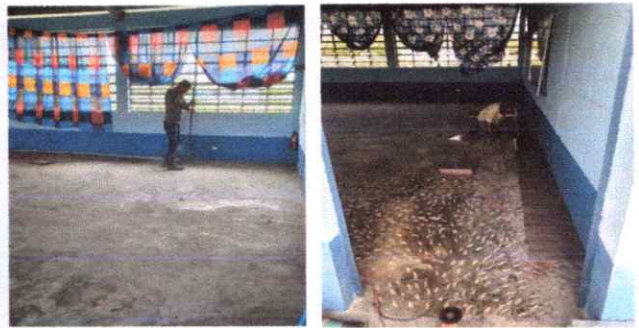
Foto 2: Proceso de sustitución de torta de concreto.
