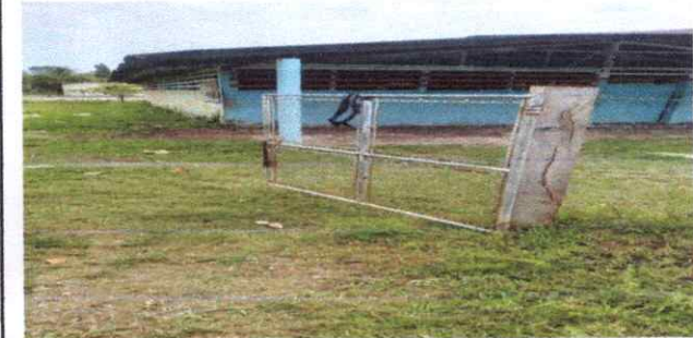
Foto 6: Sustitución de portón de metal.
