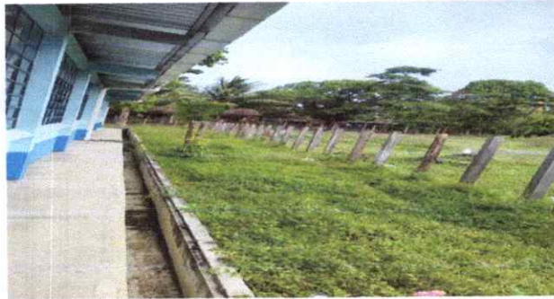
Foto 3: Reparación de cerco de alambre de pua.
