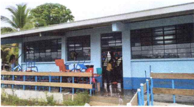
Foto 7: Sustitución de barandas de metal.
