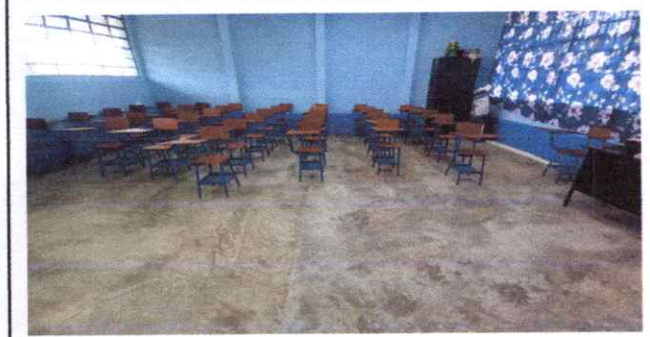
Foto 2: Sustitución de piso de torta de cemento.
