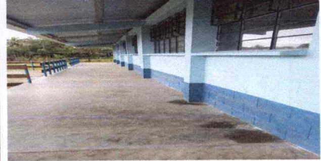
Foto 4: Pintura en muros exteriores e interiores.
