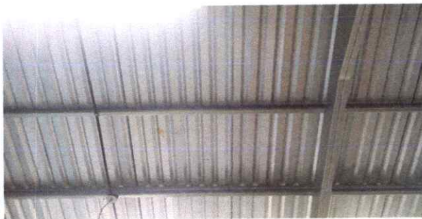
Foto 5: Reparación de pañuelos.
