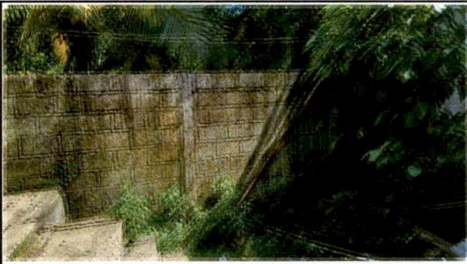
Foto 6: AMPLIACION MURO EN AULA CON REFUERZO ESTRUCTURAL.
