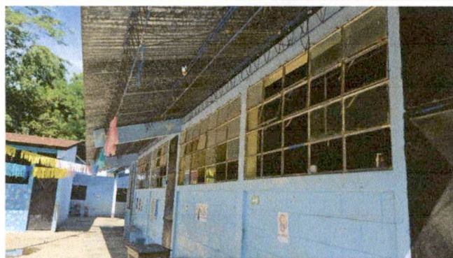
Foto 11: SUMINISTRO E INSTALACION DE BALCONES DE METAL
