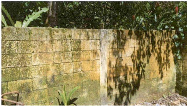
Foto 7: AMPLIACION MURO EN AULA CON REFUERZO ESTRUCTURAL
