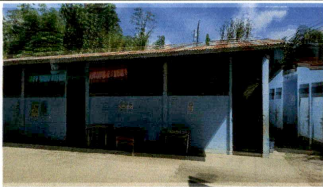
Foto 3: SUMINISTRO E INSTALACION DE BALCONES DE METAL
