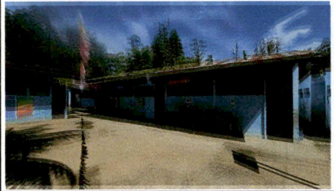
Foto 2: REMOZAMIENTO DE AULAS DE CENTRO EDUCATIVO.
