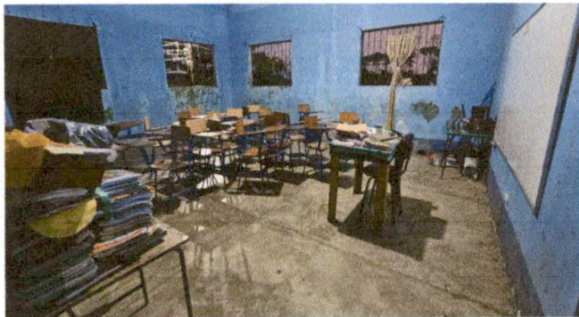
Foto 3: MODULO "A" SUMINISTRO Y COLOCACION DE PISO CERAMICO ANTIDESLIZANTE.
