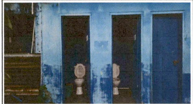
Foto 10: MODULO "C" SERVICIO SANITARIO REMOZAMIENTO DE TECHO, REMOZAMIENTO DE PUERTAS PINTURA EN GENERAL, MEJORAMIENTO DE INSTALACIONES DE AGUA POTABLE
