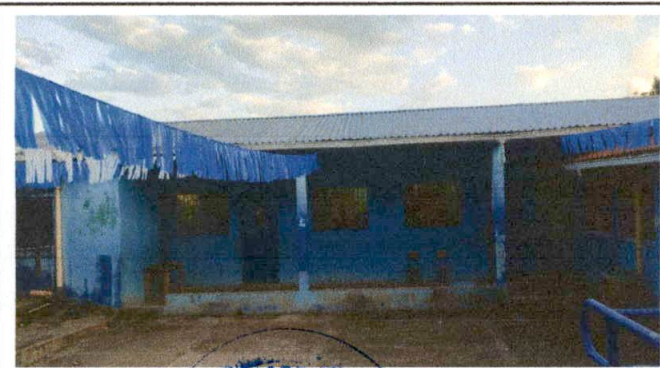
Foto 11: REMOZAMIENTO DE ESCUELA
