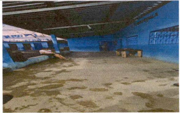
Foto 2: MODULO " B" SUMINISTRO Y COLOCACION DE PISO CERAMICO ANTIDESLIZANTE.
