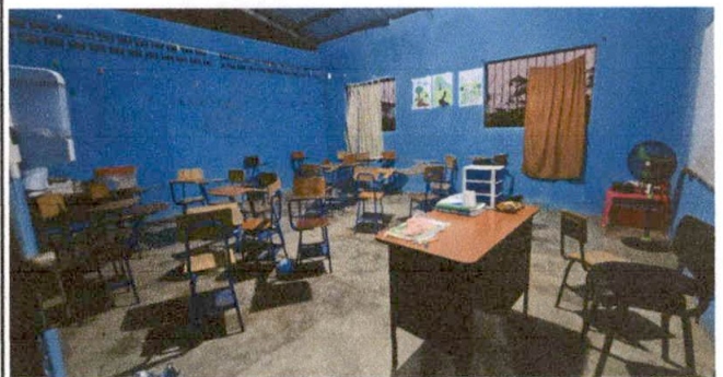
Foto 4: MODULO "A" SUMINISTRO Y COLOCACION DE PISO CERAMICO ANTIDESLIZANTE.
