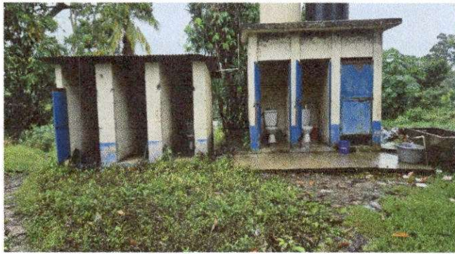
Foto 9: MODULO "B" REMOZAMIENTO DE SERVICIO SANITARIO
