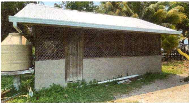
Foto 5: canal de pvc y bajada de agua en cocina, instalado.
