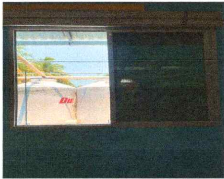
Foto 3: ventana que estaba en mal estado, reparada.
