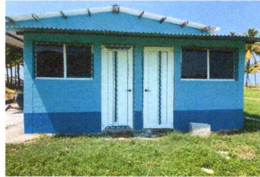
Foto 2: Instalación de ventanas upvc en servicios sanitarios, finalizada.
