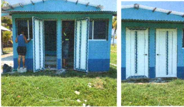
Foto1: Instalación de puertas de los baños, finalizada.
