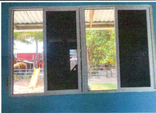
Foto 3: finalización de instalación de telas, tornillos y empaques en las ventanas
