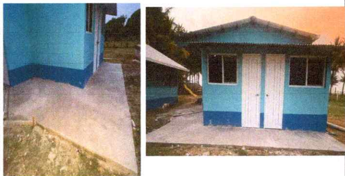
Foto 5: fudición de banqueta perimetral finalizada
