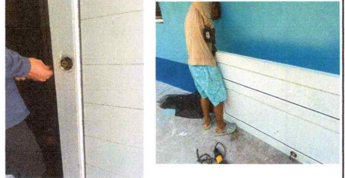
Foto 2: Cambio de chapas y bisagras.
