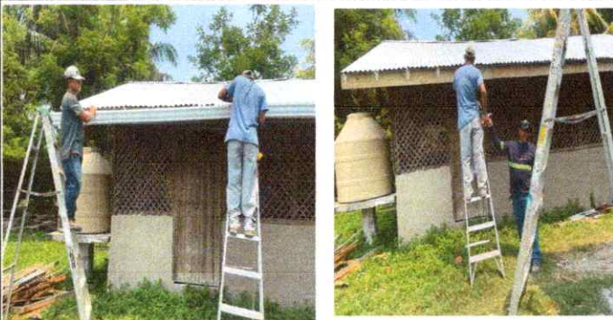
Foto 5: Instalación de canal pvc en la cocina.
