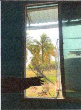
Foto 3: Telas, tornillos y empaques de las ventanas dañadas.
