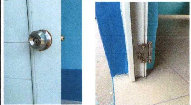
Foto 2: Puertas con chapas y con bisagras dañadas.
