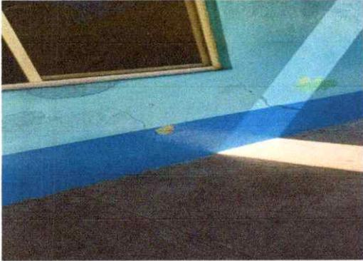
Foto1: Paredes dañadas que necesitan resane.
