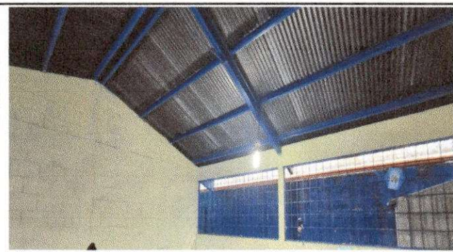
Foto 11: REMOZAMIENTO DE TECHO.
