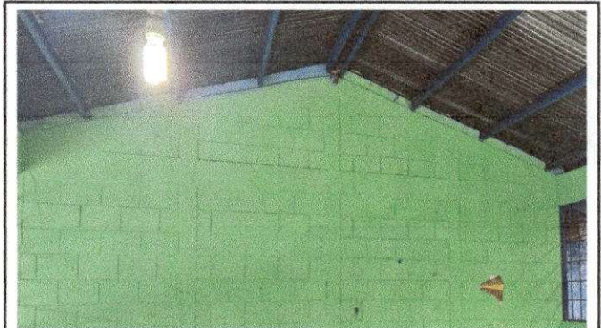
Foto 10: REMOZAMIENTO DE CIELO FALSO EN AULA DE CENTROEDUCATIVO
