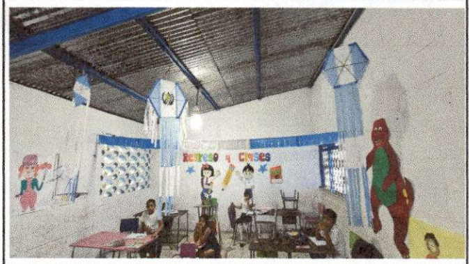
Foto 8: SUMINISTRO E INSTALACION DE CIELO FALSO EN AULA
