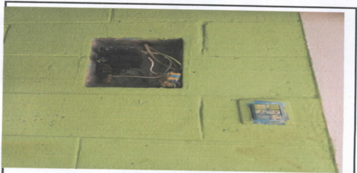
FOTO 6: REPARACION DE TABLERO DE FLIPONES Y REPARACION DE CABLEADO ELECTRICO
