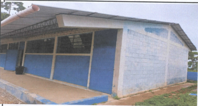
FOTO 3: PINTURA DE MUROS INTERIORES Y EXTERIORES
