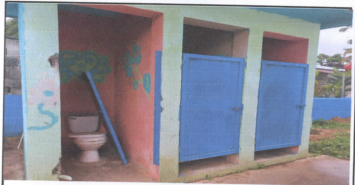
FOTO 4: MANTENIMIENTO A ESTRUCTURAS DE PUERTAS A SERVICIOS SANITARIOS
