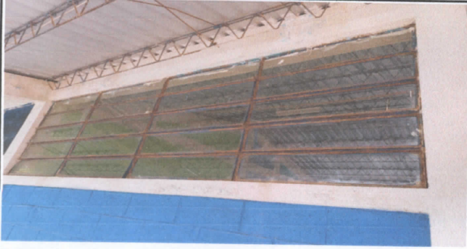
FOTO 1: SUSTITUCION DE ESTRUCTURA DE METAL Y VIDRIOS DE VENTANA
