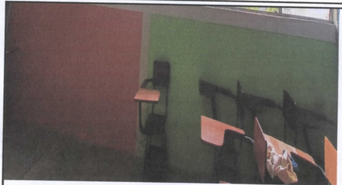
FOTO 2: SUSTITUCION DE PISO CERAMICO
