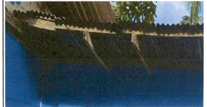
Foto 4: SUMINSTRO E INSTALACION DE ESTRUCTURA METALICA
