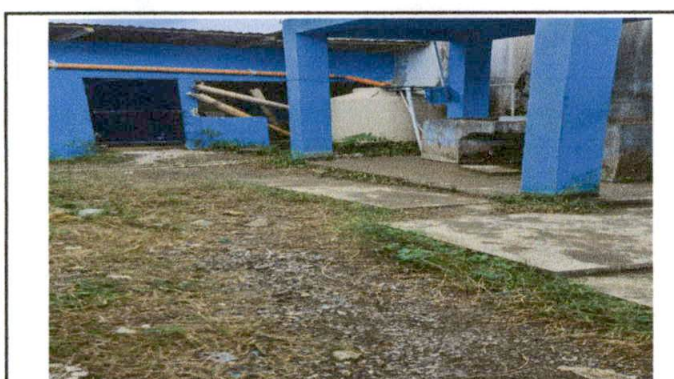
Foto 11: SUMINISTRO E INSTALACION DE PISO TORTA DE CONCRETO
