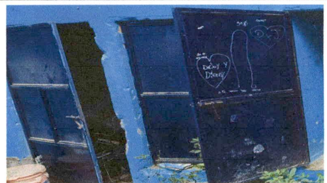
Foto 6: SUMINIISTRO E INSTALACION DE PUERTA CON PASADO
