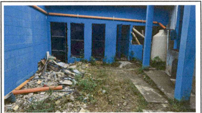
Foto 10 SUMINISTRO E INSTALACION DE PISO TORTA DE CONCRETO
