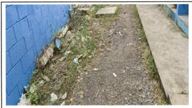
Foto 9 SUMINISTRO E INSTALACION DE PISO TORTA DE CONCRETO
