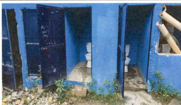
Foto 5: REMOZAMIENTO SERVICIO SANITARIO
