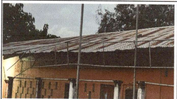
Foto 4: MODULO "A" AREA DE TECHO A REMOZAR CON LAMINA TROQUELADA.
