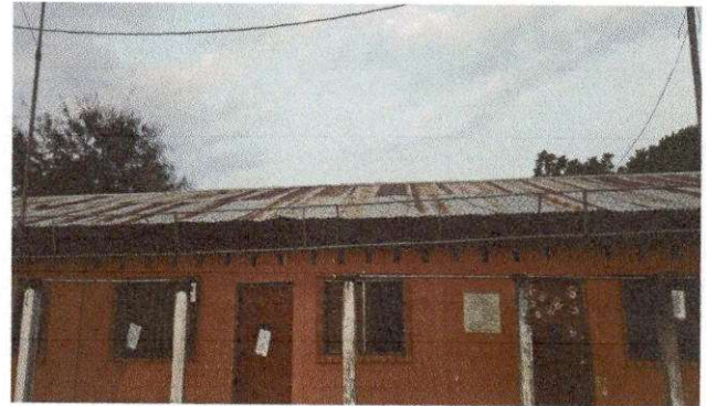
Foto 2: MODULO "A" AREA DE TECHO A REMOZAR, SUMINISTRO E INSTALACION DE LAMINA TROQUELADA CALIBRE 26.
