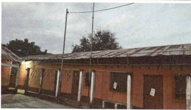
Foto 3: MODULO "A" AREA DE TECHO A REMOZAR, SUMINISTRO E INSTALACION DE LAMINA TROQUELADA CALIBRE 26.
