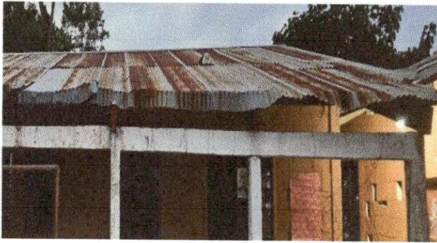
Foto 9 MODULO "B" AREA DE TECHO A REMOZAR, SUMINISTRO E INSTALACION DE LAMINA TROQUELADA CALIBRE 26.
