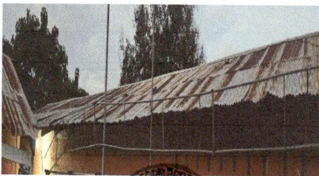
Foto 5: AREA DE TECHO A REMOZAR CON LAMINA TROQUELADA.
