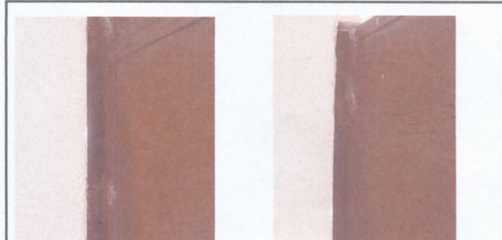
Foto No. 30 mantenimiento de puertas de metal.
