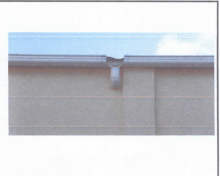
foto no. 10 mantenimiento de reposadera, y foto No. 11 sustitución de canal de pvc .
