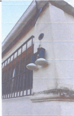
foto No. 5 reparación de repello y cernido de paredes, pintura exterior. Foto No. 6 sustitución de focos reflectores para exterior y su protector
