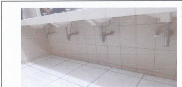
Foto No. 29 sustitución de mezcladora de lavamanos
