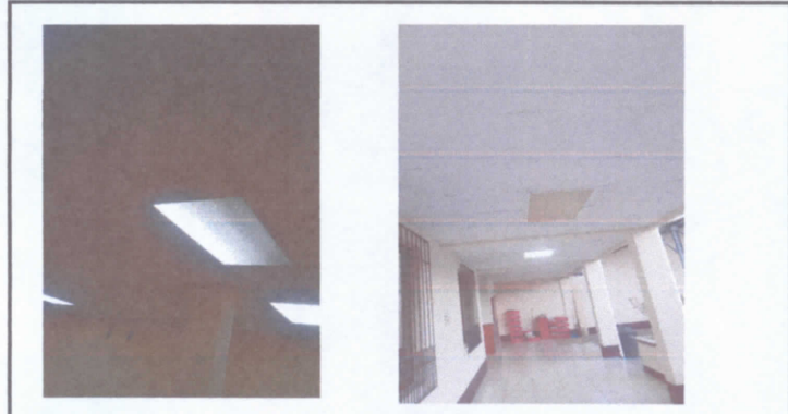
Foto No. 27 y 28 sustitución de lamparas de 2x40
