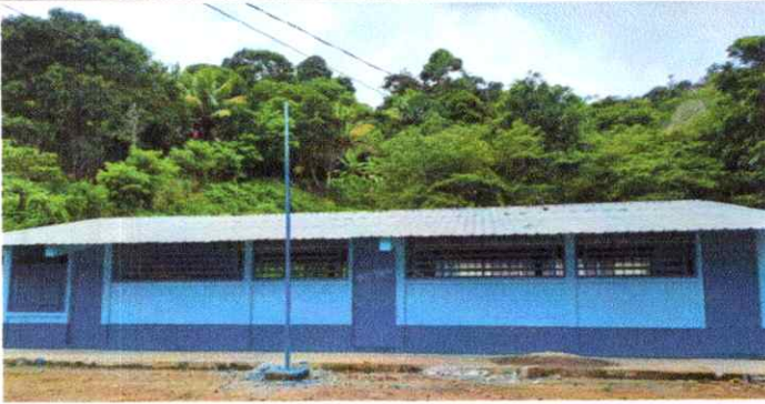
Foto1: Sustitución de Puerta
