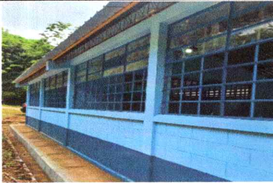
Foto 3: Mantenimiento a estructura de metal de ventanas
