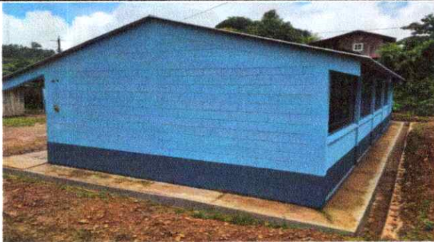
Foto 5: Pintura de Muros exteriores e interiores
