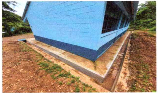
Foto 4: Reparación de cuneta de concreto
