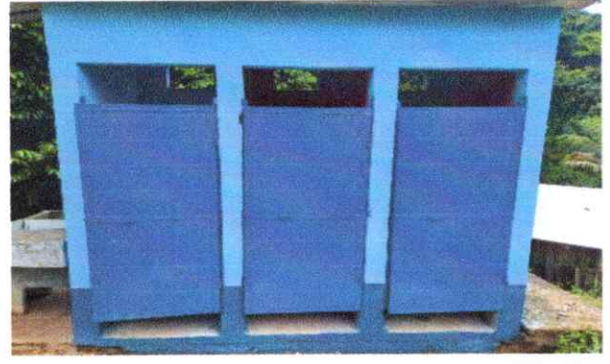
Foto 2: Sustitución de servicios sanitarios
