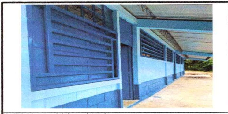
Foto 5: Sustrucciones de balcones de Metal.
