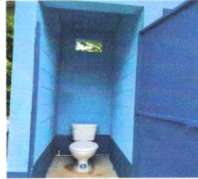
Foto 6: Sustitución de inodoros
