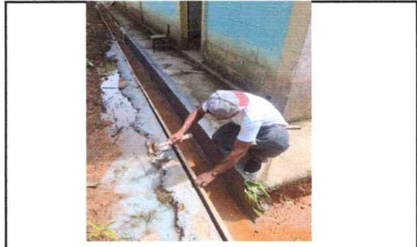
Foto 4: Reparación de cuneta de concreto
