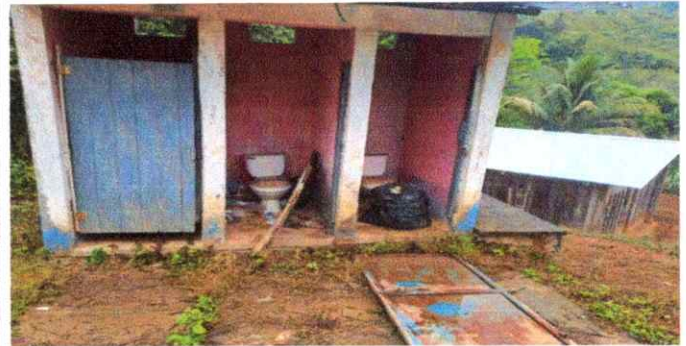
Foto 2: Sustitución de servicios sanitarios
