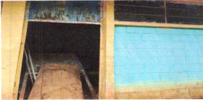
Foto1: Sustitución de Puerta
