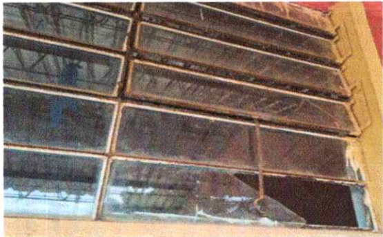
Foto 3: Mantenimiento a estructura de metal de ventanas
