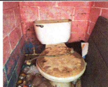
Foto 6: Sustitución de inodoros
