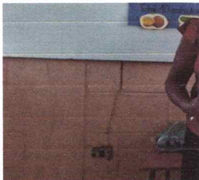
Foto 3: Sustrucción de tomacorrientes dobles
