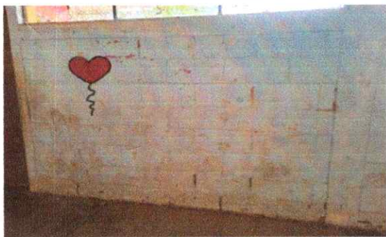
Foto 5: Pintura de Muros exteriores e interiores
