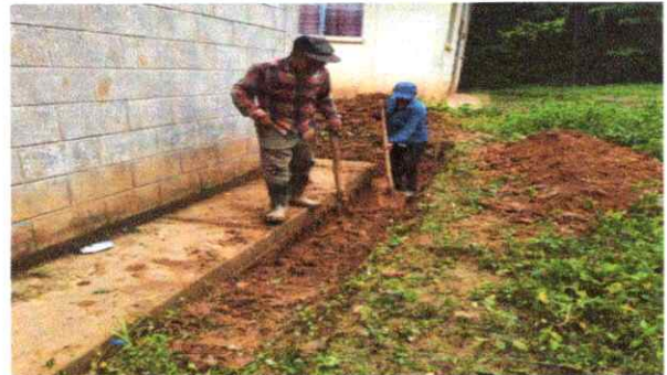
Foto 4: Reparación de cuneta de concreto
