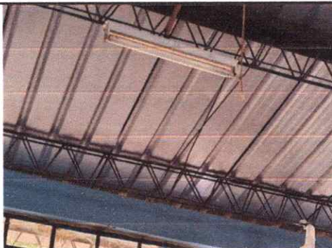
Foto 2: Sustrucción de Lámparas
