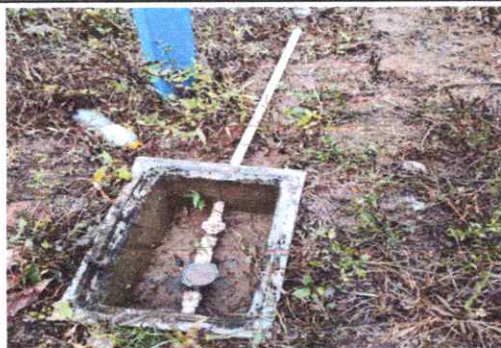
Foto 1: Sustrucción de tubería línea principal
