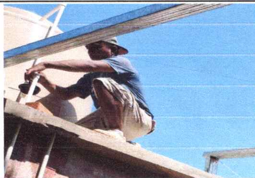
Foto 4: Sustrucción de depósito de agua de 1100lt
