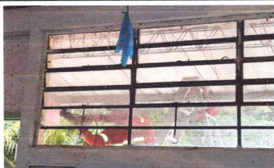
Foto 5: Sustrucciones de balcones de Metal.
