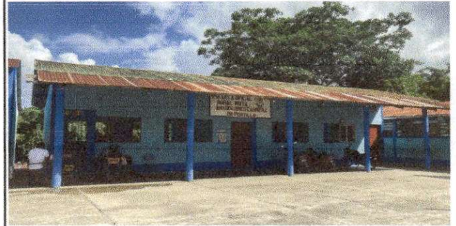
Foto 2: REMOZAMIENTO DE AULAS
