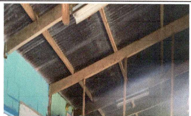
Foto 10: : SUMINISTRO E INSTALACION DE ESTRUCTURA METALICA
