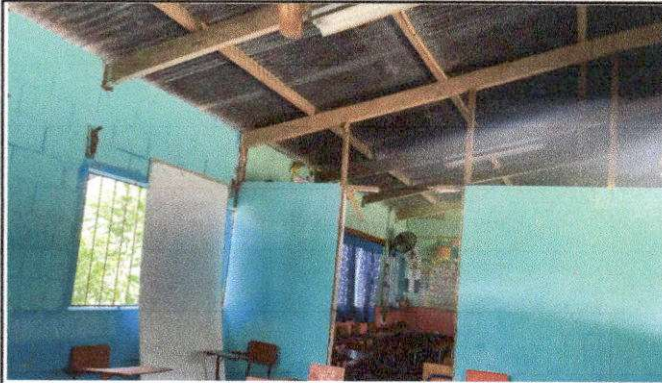
Foto 7 :: SUMINISTRO E INSTALACION DE ESTRUCTURA METALICA
