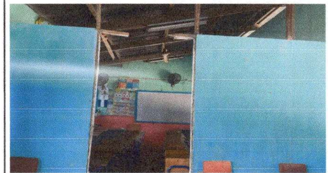
Foto 6: : SUMINISTRO E INSTALACION DE ESTRUCTURA METALICA
