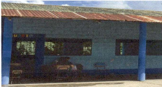
Foto 3: SUMINISTRO Y COLOCACION DE LAMINA TROQUELADA
