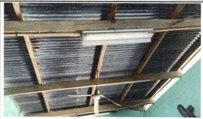
Foto 8: SUMINISTRO Y COLOCACION DE LAMINA TROQUELADA
