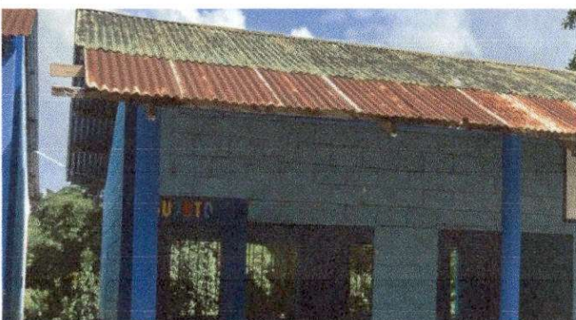
Foto 5: SUMINISTRO E INSTALACION DE ESTRUCTURA METALICA
