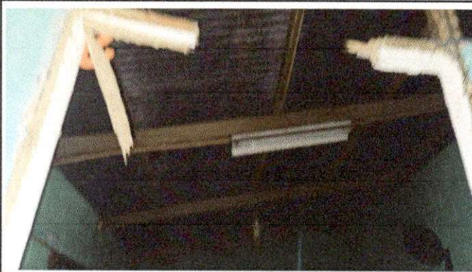
Foto 9 SUMINISTRO Y COLOCACION DE LAMINA TROQUELADA
