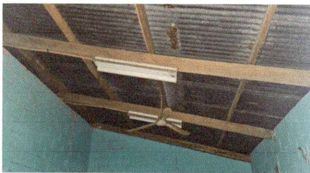
Foto 11: SUMINISTRO Y COLOCACION DE LAMINA TROQUELADA
