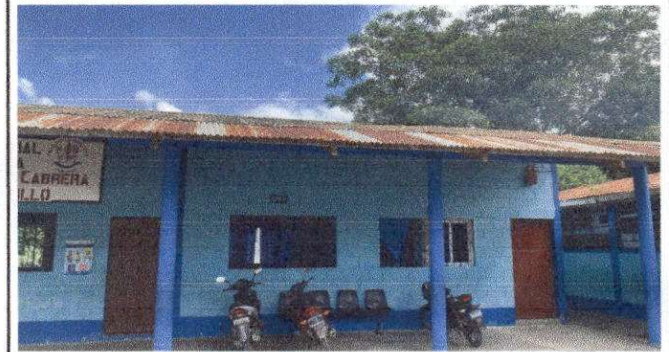
Foto 4: SUMINISTRO Y COLOCACION DE LAMINA TROQUELADA
